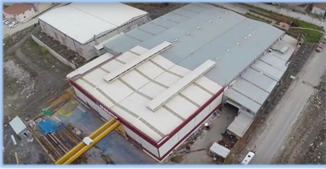
Resim 1: Yönetim Binası, 1. ve 2. Hol
